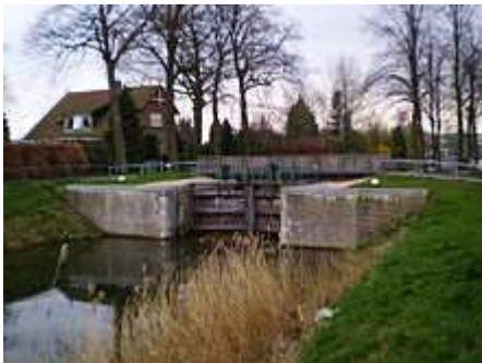
Apeldoornse Sluis in Apeldoorn met fietsbrug, gerenoveerd in 2007
